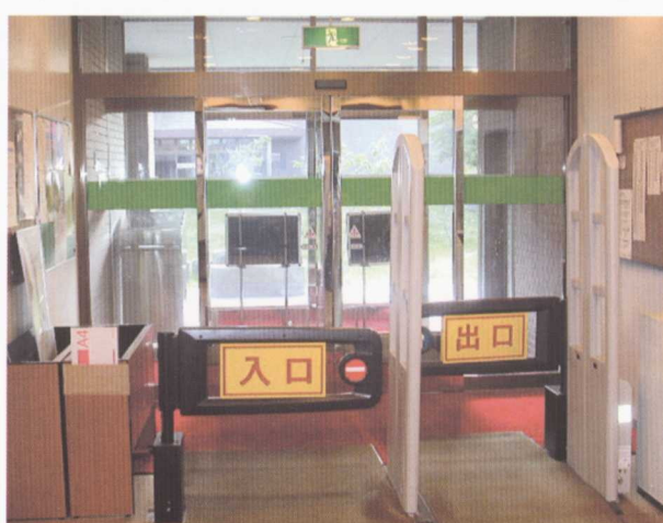
1 F (玄関入口) ブックディテクションシステム
