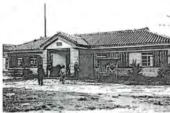
創立当初の本造瓦葺きの附属図書館 （琉球大学30年誌より）
