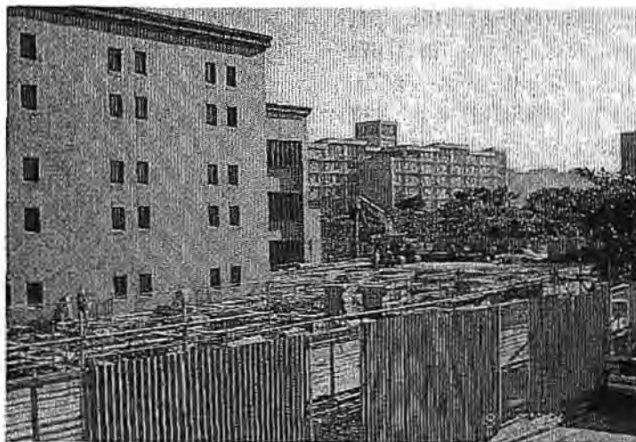
図書館増築現場
